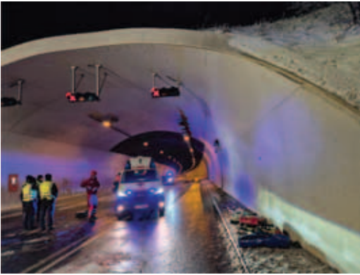
Abb. 3.1 Der Patient ist vom höchsten Punkt des Tunnelportals auf die darunterliegende Fahrbahn gesprungen [M1693]
