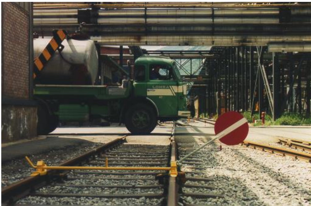
Entfernung Gleissperre zu Fahrzeug 10 - 15 m.
