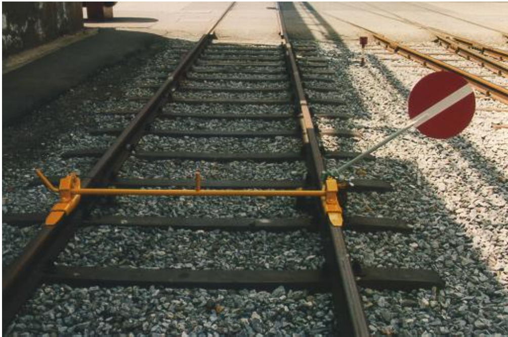
Bild 2: Gleis ist gesichert! Jetzt darf das Fahrzeug auf dem Gleis stehen.
