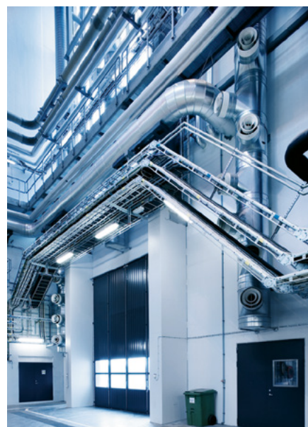
Wibe KHZV tikashylly asennettuna Gärdstaverken, Ruotsi.
