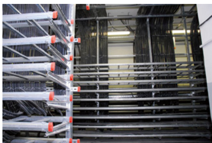
Wibe KHZP tikashylly asennettuna ydinvoimalaitokseen Venäjällä.
