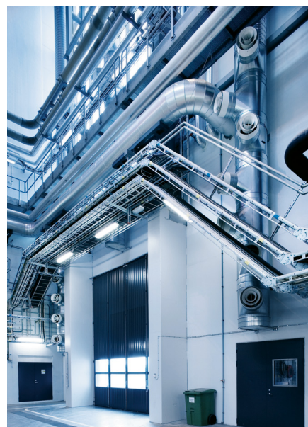
Wibe KHZV tikashylly asennettuna Gärdstaverken, Ruotsi.
