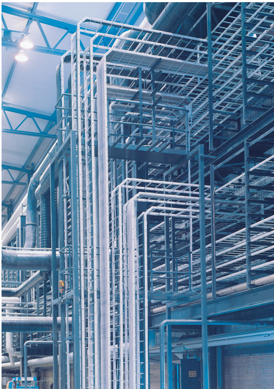
Wibe KHZ tikashylly asennettuna SSAB Terästehdas Borlänge, Ruotsi.
