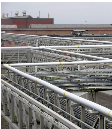
Wibe KHZV tikashylly asennettuna Outokumpu Terästehdas, Avesta Ruotsi.
